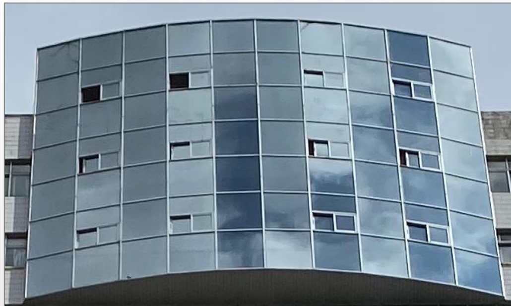
改造前现场照片
